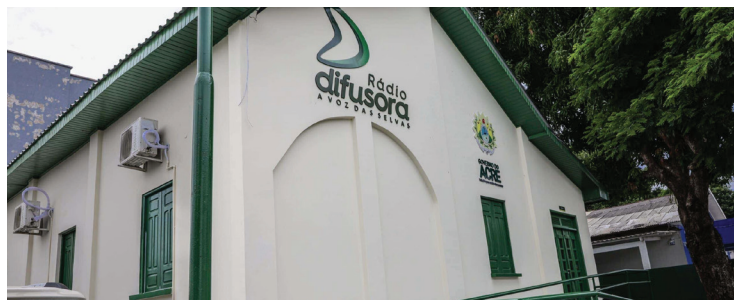
Revitalização da Rádio Difusora Acreana de Rio Branco foi entregue em novembro de 2024. Foto: José Caminha/Secom
